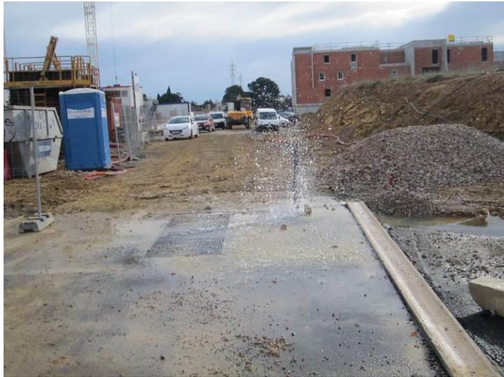
Branchement de chantier percuté par un engin (Montpellier)
