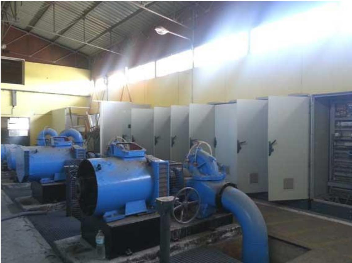
Salle des pompes, armoires désossées, rotor de moteur déposé
