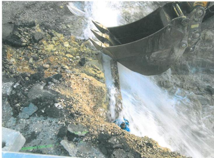
Coup de godet d'engin de chantier sur une canalisation en eau
