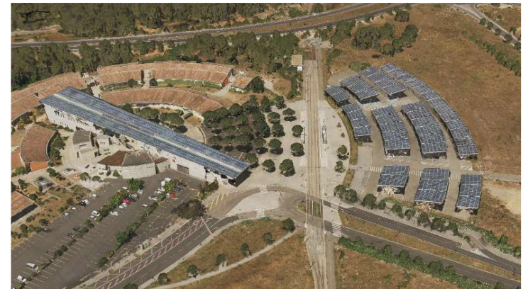
Castelnau-le-Lez - installations photovoltaïques P+R du tramway
