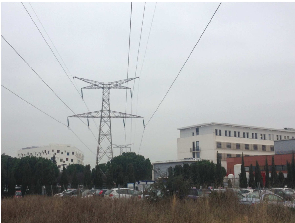
Ligne à haute tension proche de la clinique du Millénaire
